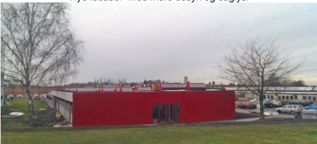
For at opnå godt dagslys til vurdering af farver etableres nye nordvendte ovenlys
