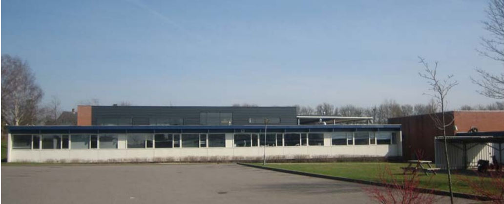
Eksisterende forhold før ombygningen
